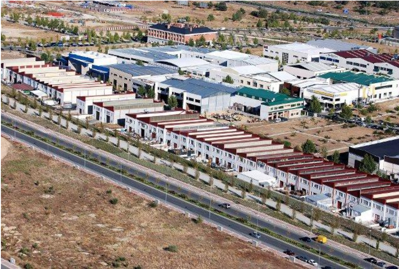
Polígono industrial en Alcorcón (Madrid)
