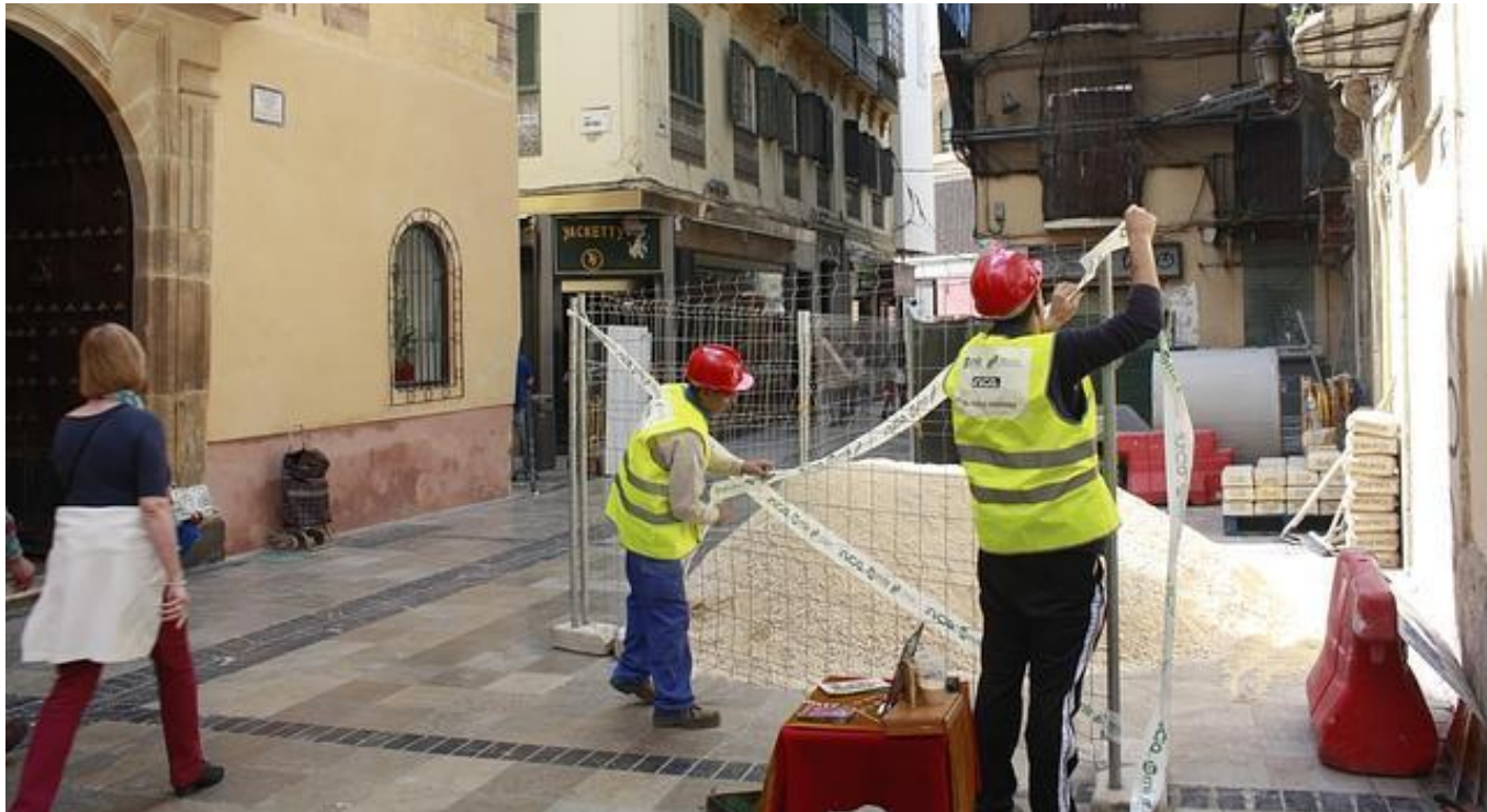
Obras de rehabilitación en la calle Granada (Málaga)
